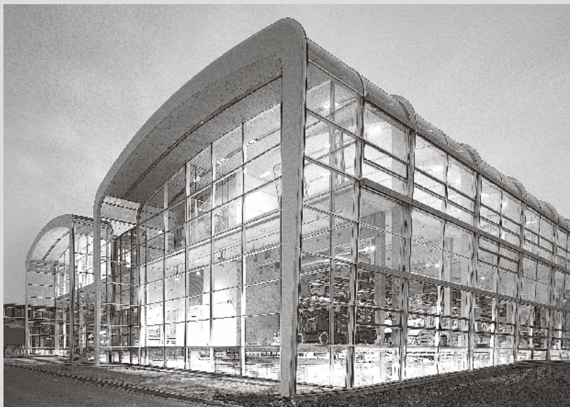
Nave de producción de Gira en Radevormwald
